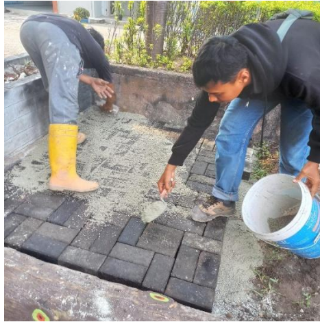
Gambar 4. 11 Proses Pemasangan Eco Paving Sumber: Dokumentasi Pribadi 2026
