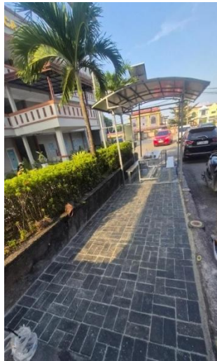
Gambar 4. 12 Hasil Akhir Pemasangan Sumber: Dokumentasi Pribadi 2026
