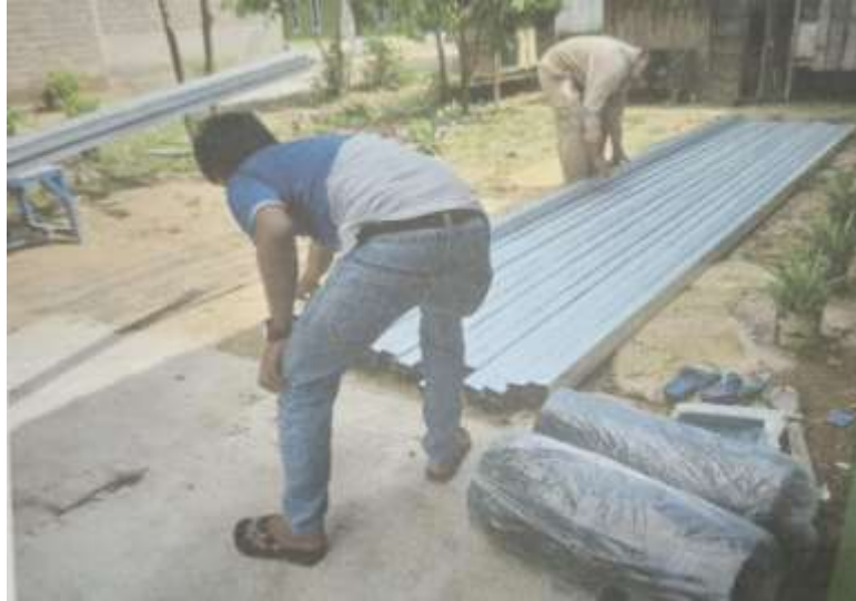
Gambar 4.6 Pemasangan Batu Miring/Bekisting Saluran Drainase RW 10
