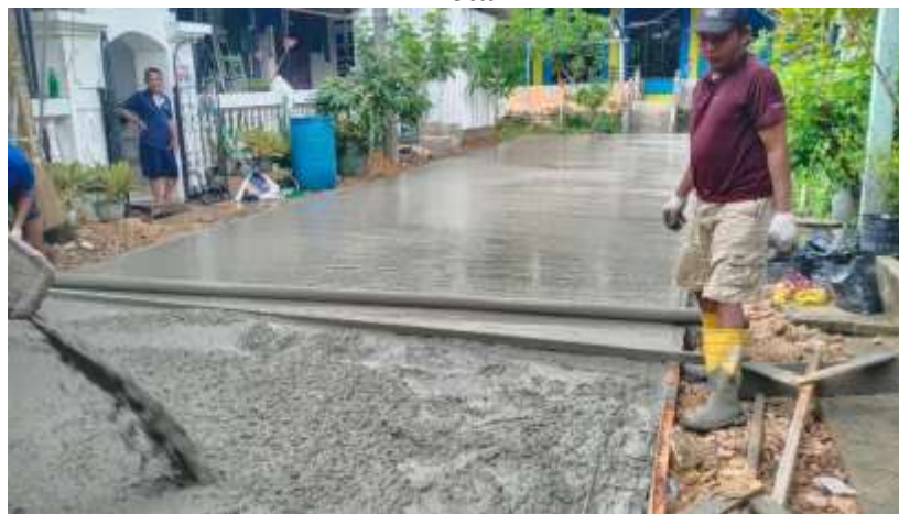
Gambar 4.12 Proses Pengecoran Semenisi Jalan di Kelurahan Sagulung Kota
