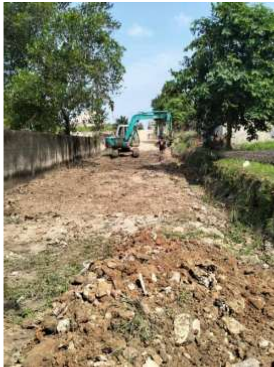
Gambar 4.5 Proses Penggalian Saluran Drainase pada Titik Proyek PSPK Tahun 2024 RT 07 RW 05
