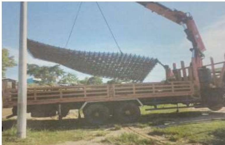
Gambar 4.7 Proses Bongkar Muat Wiremesh untuk Pengerjaan Semenisasi Jalan RW 10
