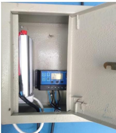
Gambar 33. Pemasangan inverter 1000 W
